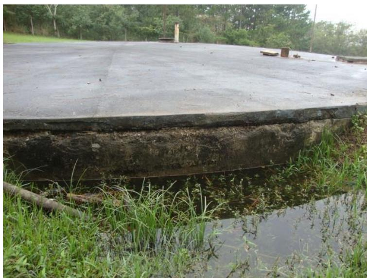
*Figura 11- Reservatório de Compensação – Ausência de sistema de drenagem. Fonte: SMS Santa Maria RS*
