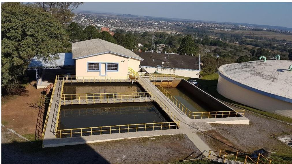
Figura 10 - Tanque de Acúmulo de Lodo e de Água de Recirculação. Fonte: Vigiagua, 2018.
